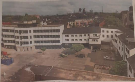
Millionenschweres Großprojekt. Auf dem einstigen Köpi-Areal mit gut 9000 Quadratmetern, gegenüber der Brauerei, werden alte Büro- und Mehrfamilienhäuser in ein Pflegezentrum umgewandelt. FOTO: TANJA PICKARTZ / FFS
