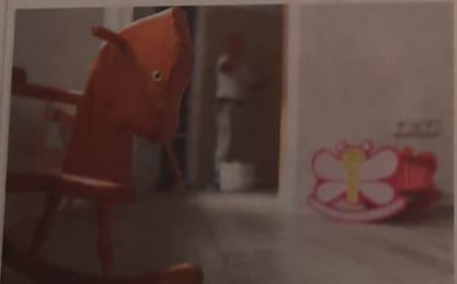
Während im restlichen Gebäudekomplex noch die Innensanierung läuft, hat in der neuen Kita schon der Endspurt begonnen. FOTO: TANJA PICKARTZ
